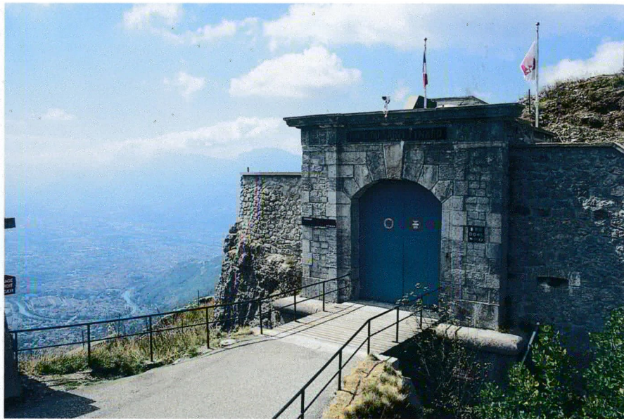
Die Hauptanlage des Fort du St-Eynard ist nur dann zugänglich, wenn die Gaststätte im Inneren geöffnet hat; sie vermittelt umfassende Ausblicke auf Grenoble → Runde 32.
