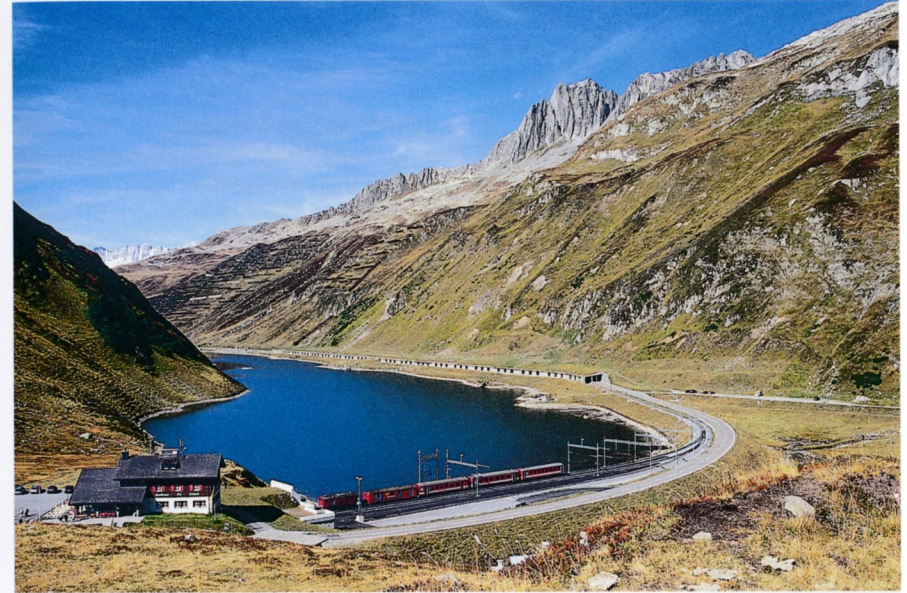
Blick auf den Oberalpsee ; die 800 m lange Lawinengalerie wurde sowohl zum Schutz der Scheitelstrecke als auch der Oberalpbahn errichtet → Runde 2.
