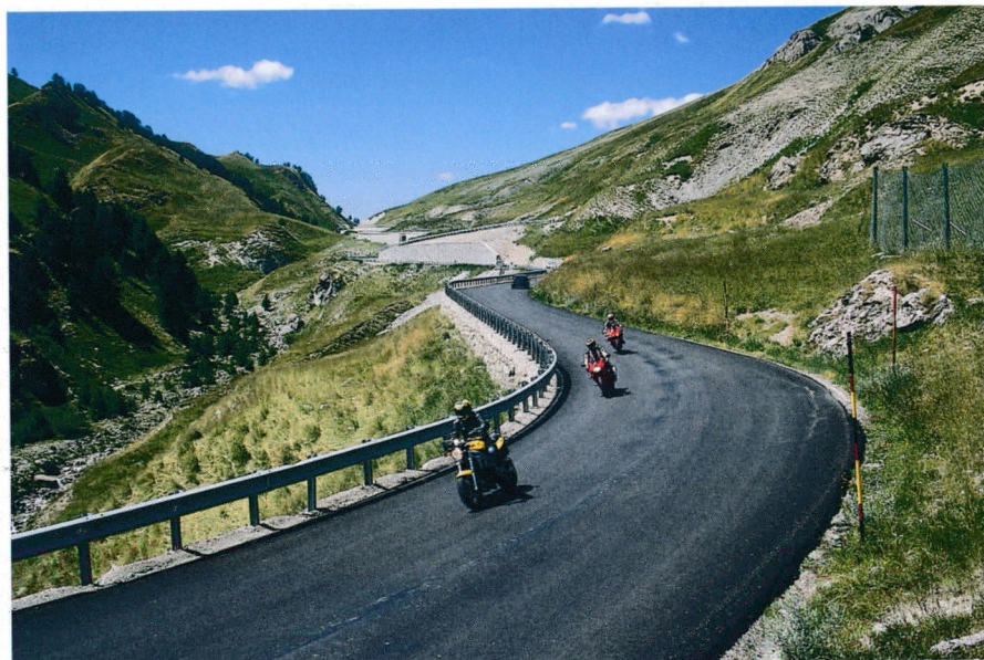
Der beidseitig gute Ausbauzustand des Colle della Maddalena/Col de Larche erlaubt eine zügige Fahrweise; im Bild die SO-Rampe auf ital. Gebiet → Runde 38.
