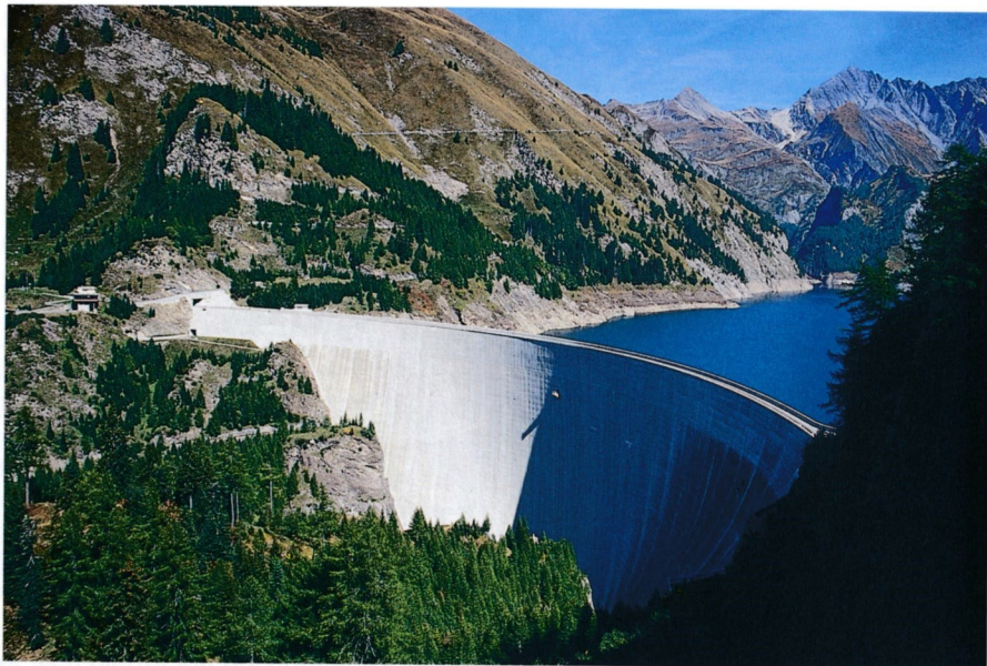
Blick auf die Staumauer des Lago di Luzzzone vom Portal des Felstunnels → Runde 1.
