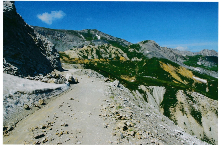
Am Colle Cologna ist die Maira-Stura-Kammstraße den Witterungseinflüssen besonders stark ausgesetzt; Steine, Geröll und Hangrutschungen bilden immer wieder Hindernisse → Runde 20.
