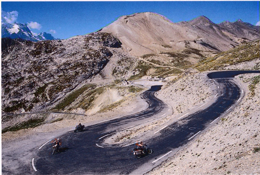
Letzter Anstieg zur Passhöhe des Col du Galibier ; wahlweise kann man auch durch den Scheiteltunnel fahren. Im Bild die Südseite → Runde 30 und 31.
