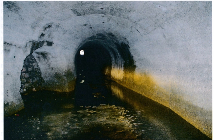
Der 850 m lange, gekrümmte, unbeleuchtete Tunnel zum Monte Jafferau lässt sich als eine der Schlüsselstellen bezeichnen; in ihm steht oft das Wasser von Wand zu Wand. → Runde 17.
