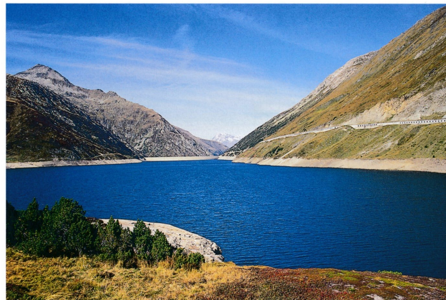
Auf der Scheitelhöhe des Lukmanierpasses schützt eine 2 km lange Galerie am ö. Ufer des aufgestauten Lai da Sontga Maria vor Steinschlag und Lawinen → Runde 1.
