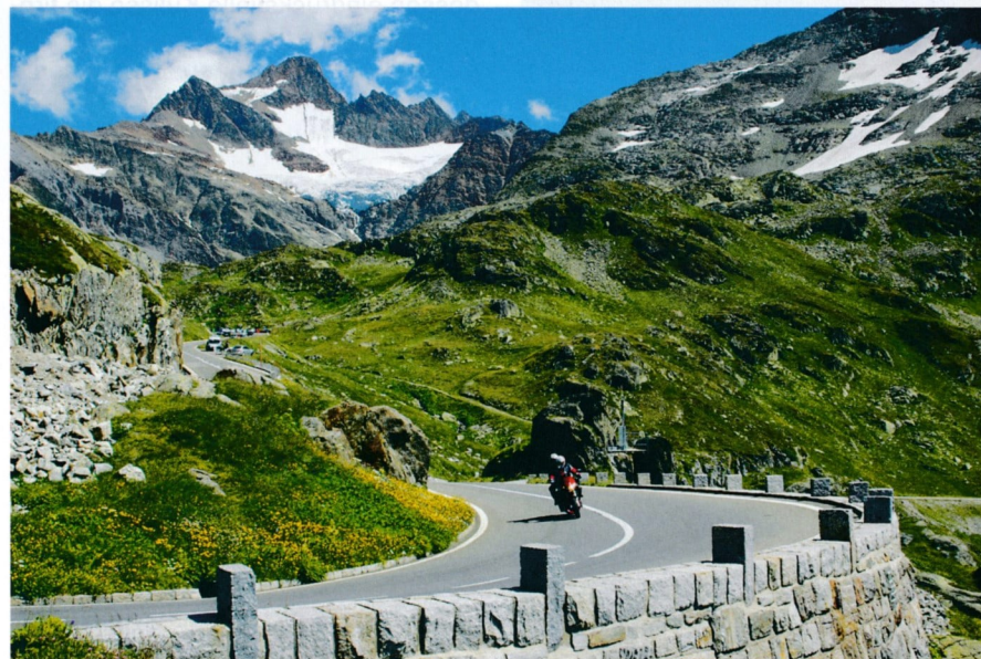
Die großzügig trassierte Susten-Pass-Straße wurde in den Jahren 1938-45 erbaut; statt Beton wurden dem Auge gefällige Natursteine für die Stützmauern verwendet → Runde 5.
