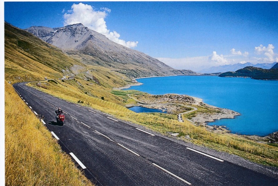
Die breit ausgebaute D 1006 verläuft am Ostufer des Lac du Mont Cenis und führt über den Plan des Fontainettes; am Seeende ist die Staumauer zu erkennen → Runde 17.
