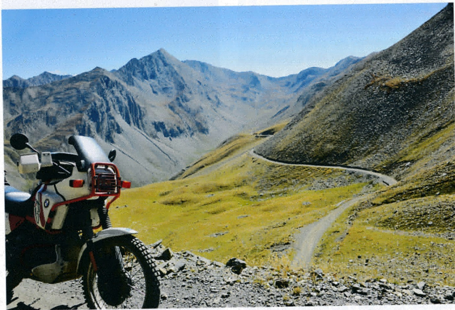
Starken Witterungseinflüssen ausgesetzt ist die SO-Rampe des Col de Parpaillon ; ihr Zustand ist deshalb ein wechselhafter → Runde 36. Foto Margit und Thomas Titscher
